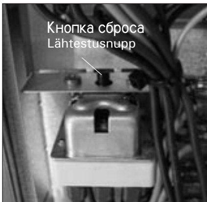
Рис. 3. Защита от перегрева Joonis 3. Ülekuumenemiskaitse
